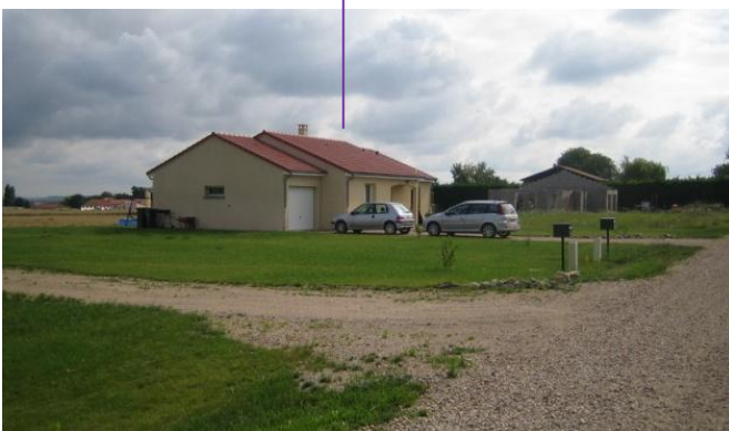
Chazelle : constructions récentes en contact direct avec les terres agricoles.
